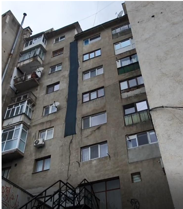
Figura 4: rosturi seismice tratate necorespunzător
