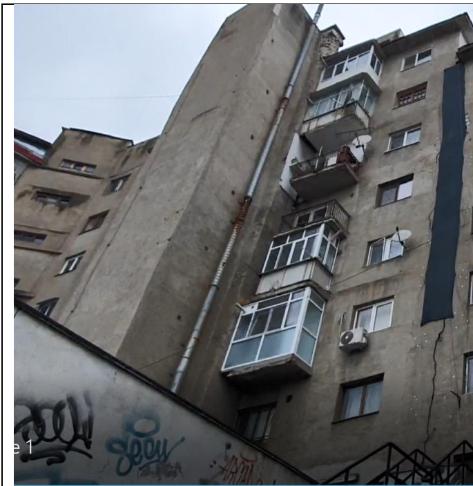
Figura 7: Fațada Sudică G2
