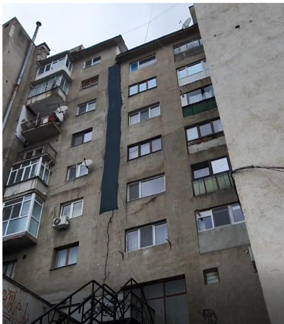
Figura 4: rosturi seismice tratate necorespunzător
