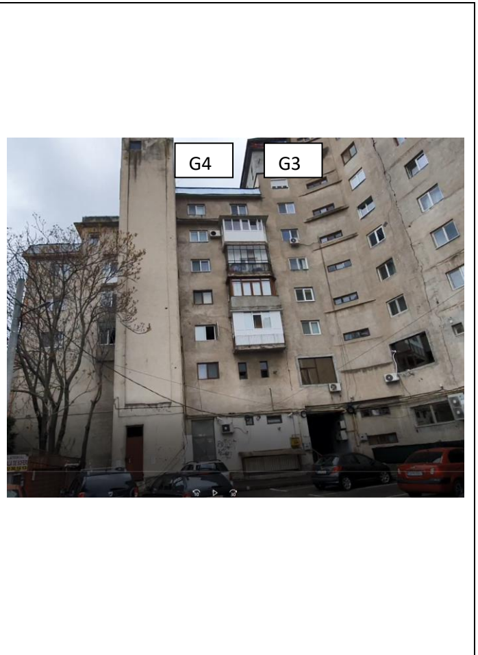
Figura 10: Fațada Sud vest G3 si G4
