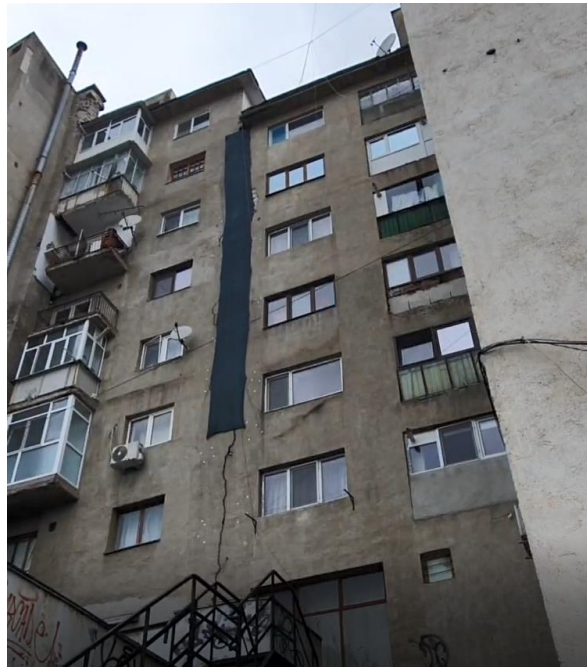
Figura 4: rosturi seismice tratate necorespunzător
